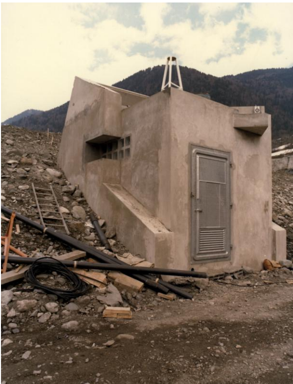
Cabine de réception des appareils d'auscultation du barrage du Verney au 1 er plan : le furet hydraulique (Photo Artechnique-Piccardy)
