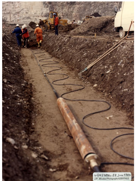
Construction du barrage de Grand'Maison : Mise en place d'un élongamètre (Photo Mirabel)
