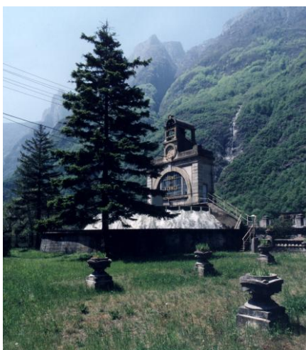
Usine hydroélectrique des Vernes, construite en 1918 sur la Romanche et toujours en activité
