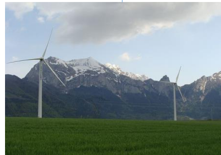
Parc de 2 éoliennes à Pellafof – 3 MW
