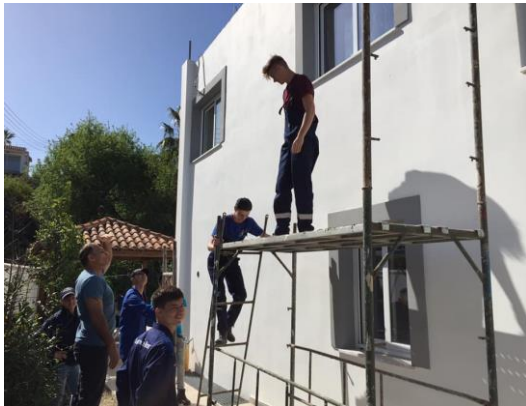
Montarea schelei pentru realizarea tencuiei
