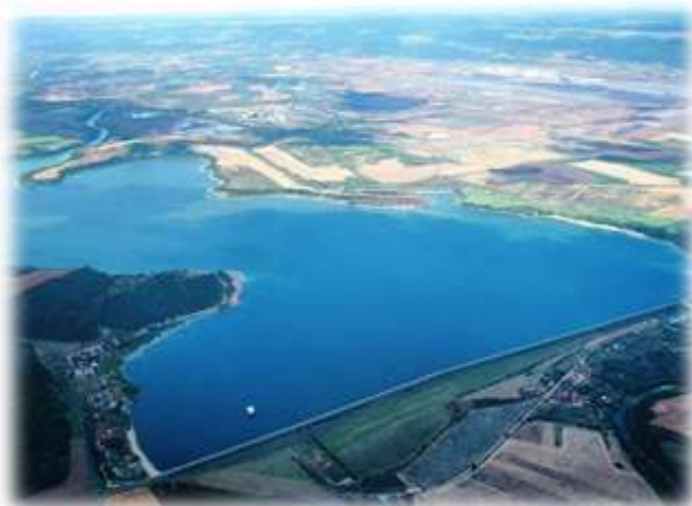
Vodní nádrž Nechanice
