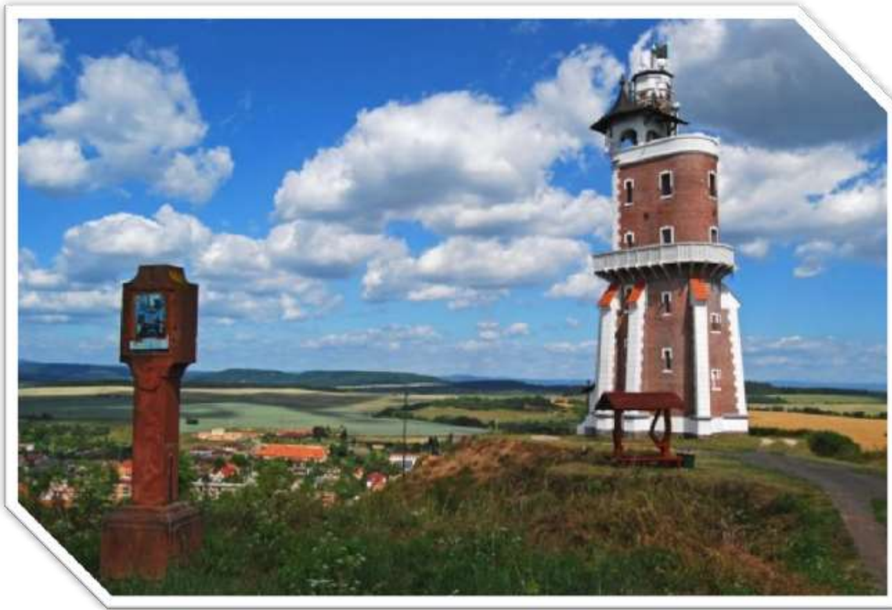
Schillerova rozhledna - Kryry
