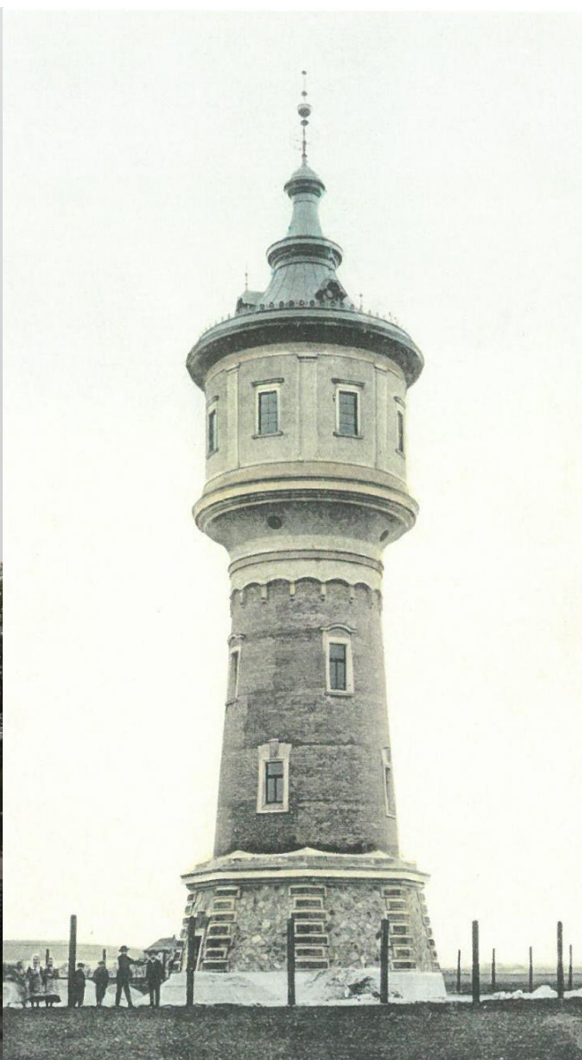
Vodárenská věž Davídkova
