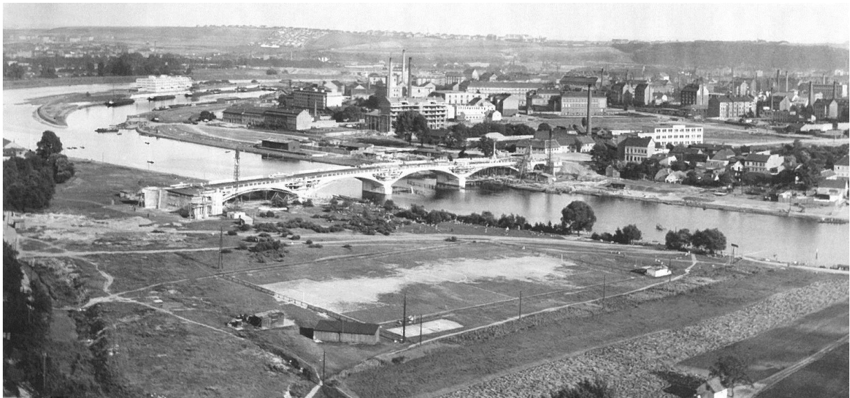
Stavba mostu Barikádníků
