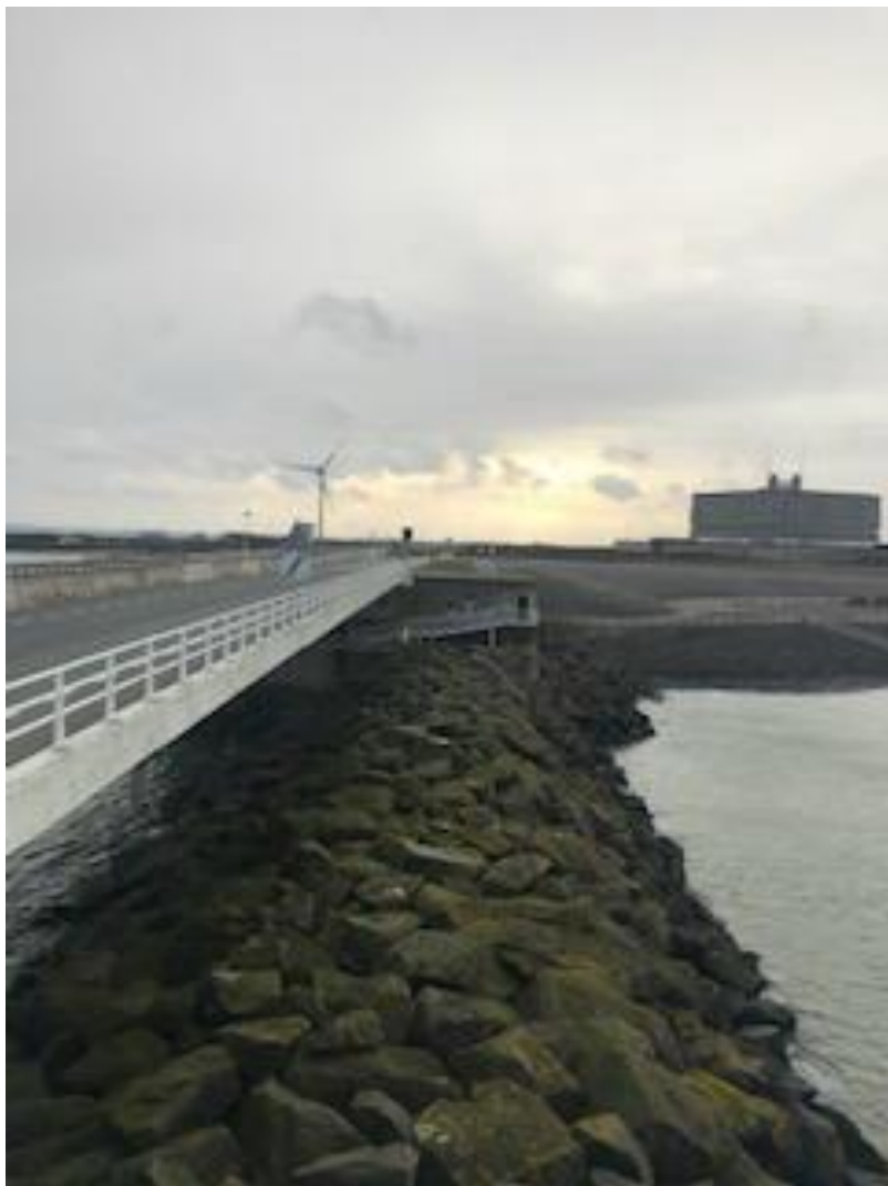
În drum spre baraj
