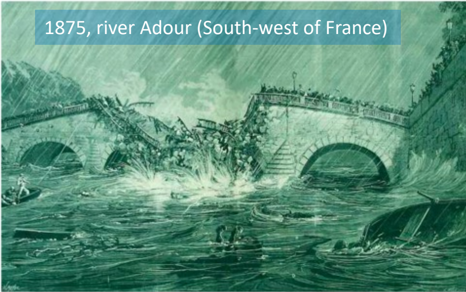
Dessin du pont de Tarbes sur l'Adour lors de son effondrement... Source Christophe Cathelain - ioucrup65.fr
