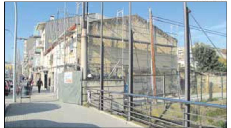
ENDERROC Permetrà doblar l'amplada de la vorera del carrer Dunant
