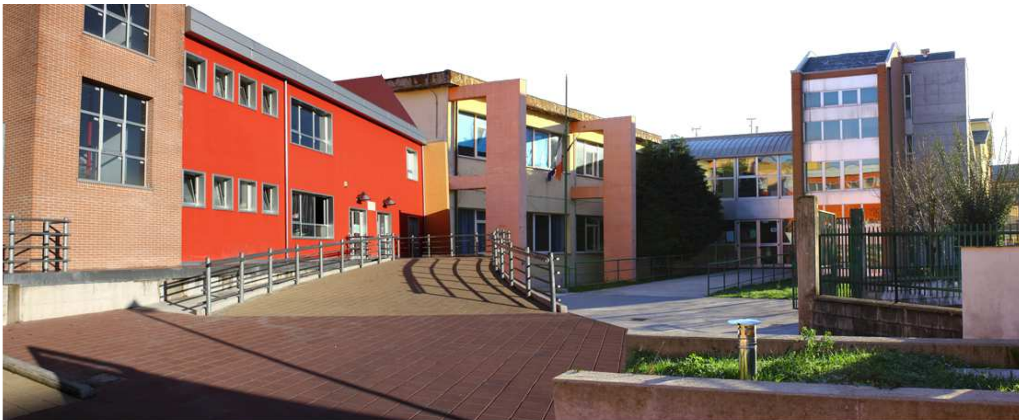
Italy: Istituto di Istruzione Secondaria Superiore, Bojano
