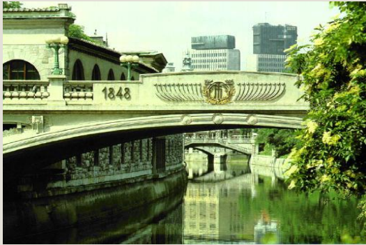
Cobblers' bridge, Šuštarški most
