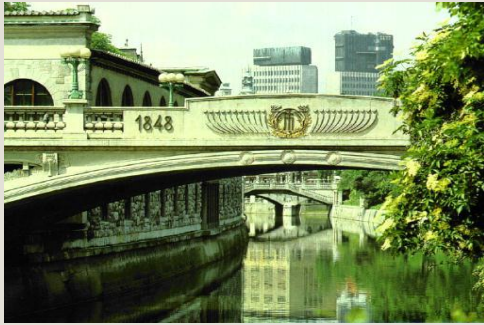
Cobblers' bridge, Šuštarški most
