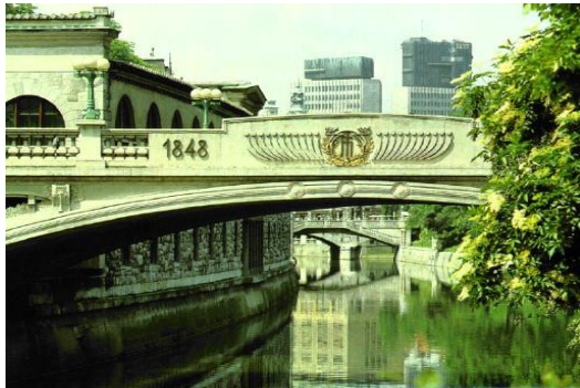
Cobblers' bridge, Šuštarški most
