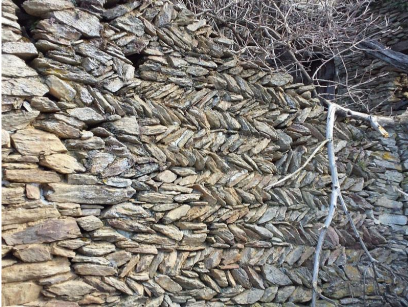
Muro saraceno, Bobbio Pellice
