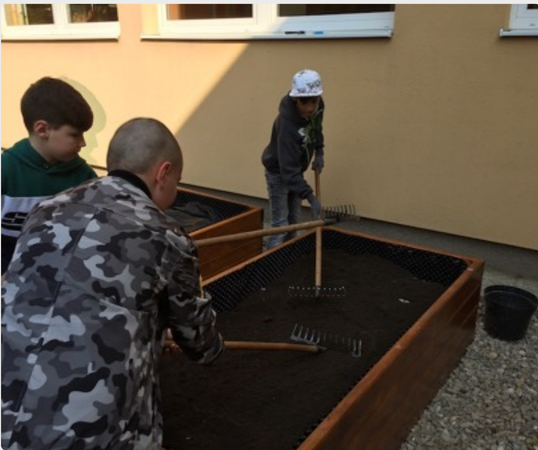
Obr. č. 8 Vytvorenie vrchnej vrstvy - substrát
