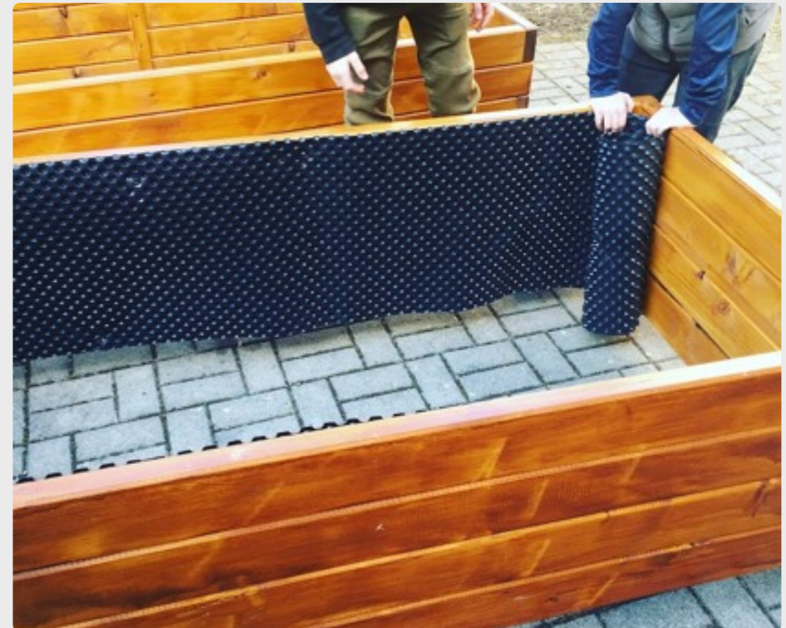
Obr. č. 5 Spevnenie bokov záhonov nopovou fóliou
