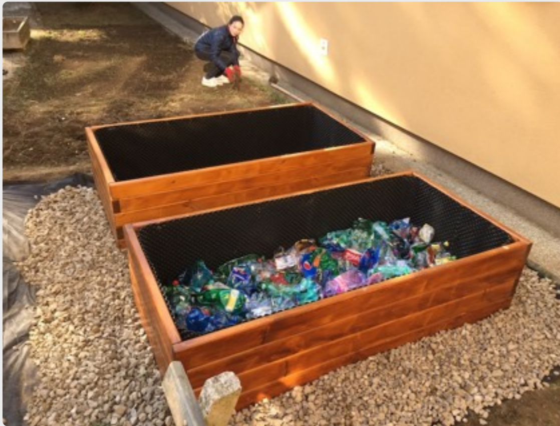
Obr. č. 6 Príprava spodnej vrstvy vyvýšených záhonov
