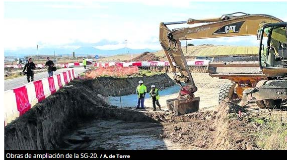
Obras de ampliación de la SG-20. / A. de Torre
