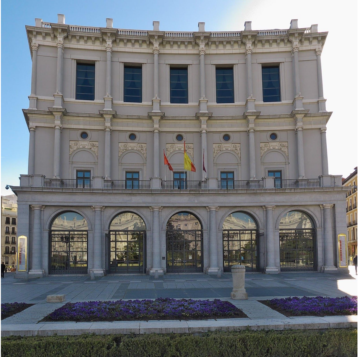
FACHADA PRINCIPAL DEL TEATRO DE LA ÓPERA
