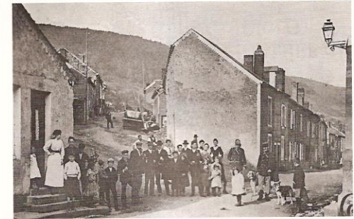
NOUZON - La Forge, rue de la Chappe et de Lorraine
